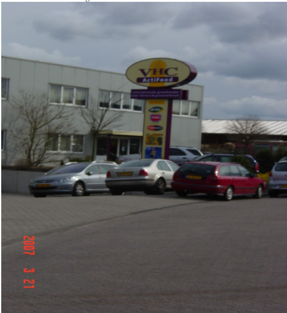
Een “forse” vrijstaande reclame voor het bedrijfsgebouw.
