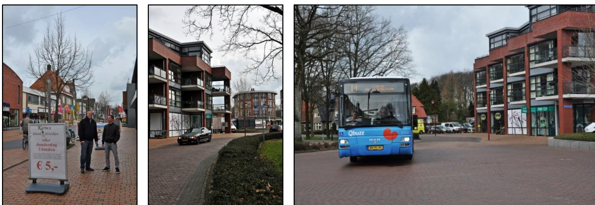
Woonappartementen bij het winkelcentrum en het busstation in Oosterwolde.
